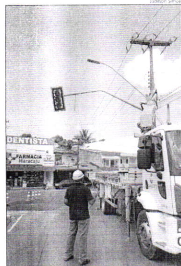
SMTT dá sequência à instalação na Avenida Juscelino Kubitschek
